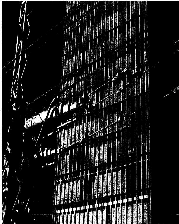
圖 1-14 站內短張力區使用彈簧式平衡器適用拉力有 1000kgf 與 2000kgf2 種型式
