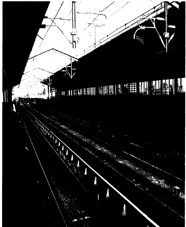
圖 1-24 車站內版式軌道
