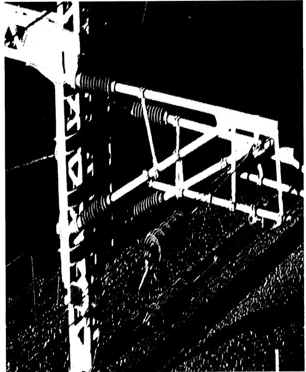
圖 1-2 隔電子塗上綠色矽膏 防止因瓷體不潔發生閃絡事故
