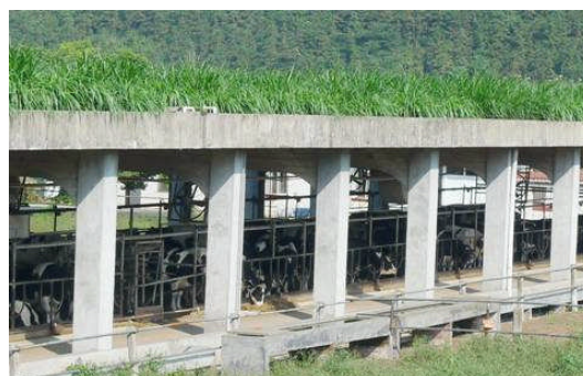
圖 8. 牛舍屋頂平台種植狼尾草可降低熱效應及生產牧草。
