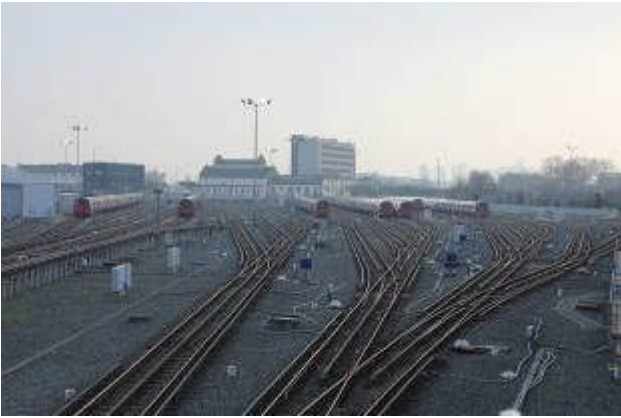
機廠控制室後方之駐車區及轉換軌
