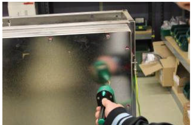
TIU 接地測試(接地螺栓與後方可拆式面板)
