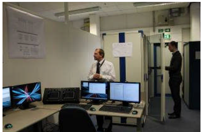
桃園機場捷運 ATS 模擬測試(設備建構中)
