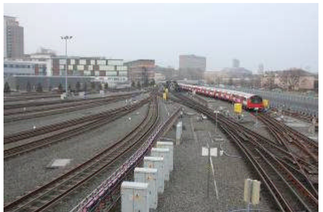
機廠進出廠線及轉換軌
