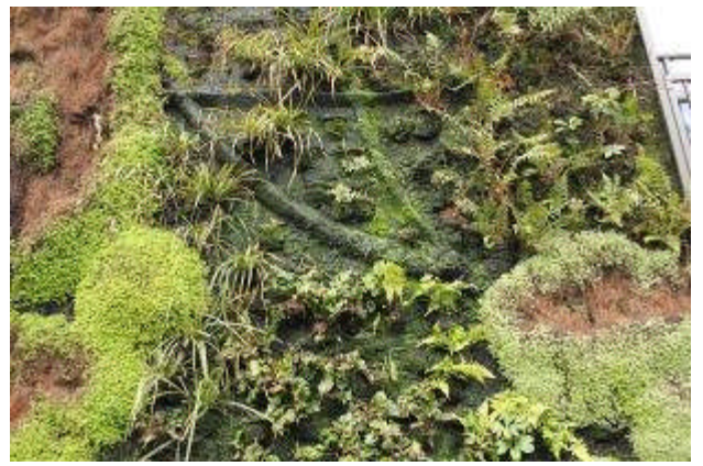
倫敦市區飯店外牆植生綠化
