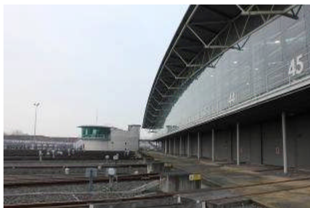
維修廠(圖右)及控制室(圖中)
