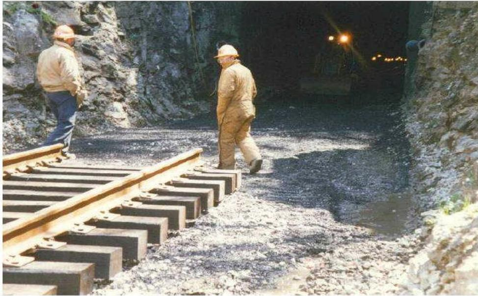
圖17 隧道內鋪設全斷面HMA -1
