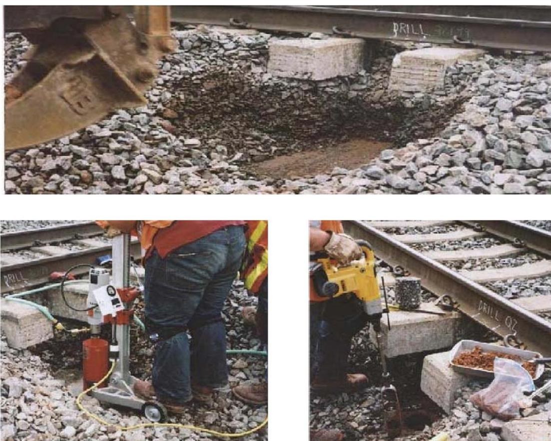
圖19 對現有營運線之HMA墊層鑽心取樣
