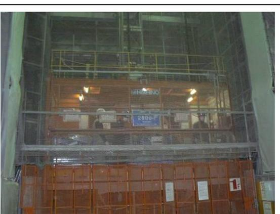
照 12 積載荷重 2800 公斤之施工電梯(來源:大成建設工地現場拍攝)
