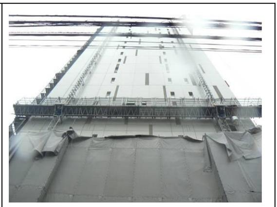
照 45 外牆採爬升式施工架之外觀(來
