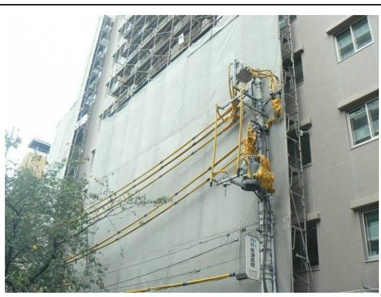
照 26 10 樓建物外牆整修鄰近架空高壓
