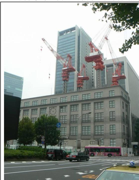
照 13 現場設置 4 部額定荷重 150 公噸之塔吊(來源:大成建設工地現場拍攝)
