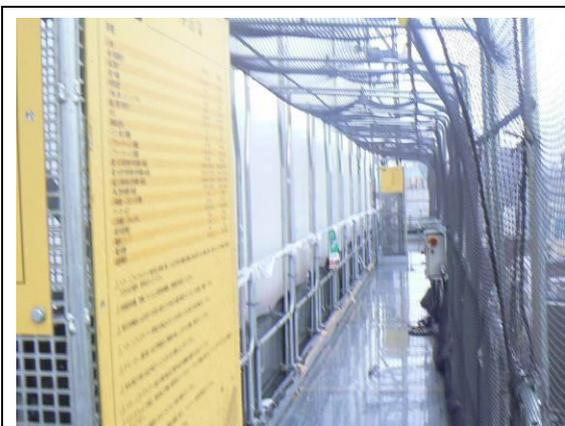
照 44 外牆採爬升式施工架之內觀(來源:
