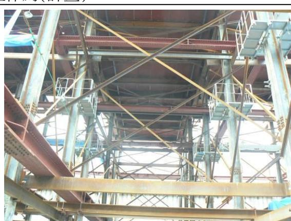
照 6 施工構台鋼梁支撐加上許多斜向拉桿或繫條(來源:大成建設工地現場)
