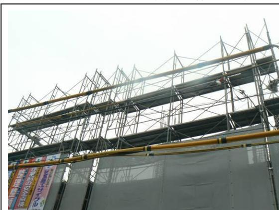
圖 21 施工架搭設穩固交叉拉桿完整(來源:著者東京街道隨機取景)
