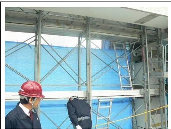
照 35 爬昇式施工架完整且穩固(來源:鹿島建設工地現場拍攝)
