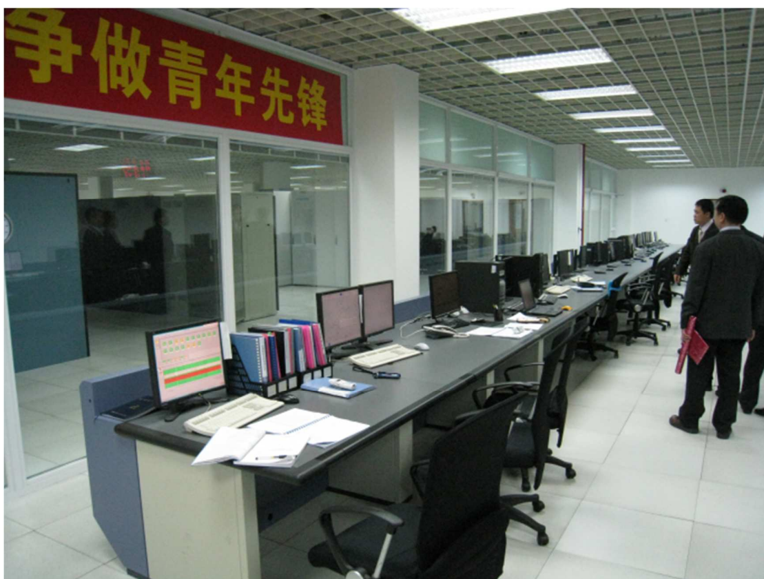
圖 3-7 參訪廣州區域管制中心設備監控室
