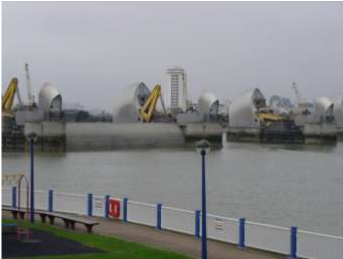
圖：泰晤士河防水閘門（閘門造型設計仿雪梨歌劇院，左側乙扇閘門呈啟動狀態）
