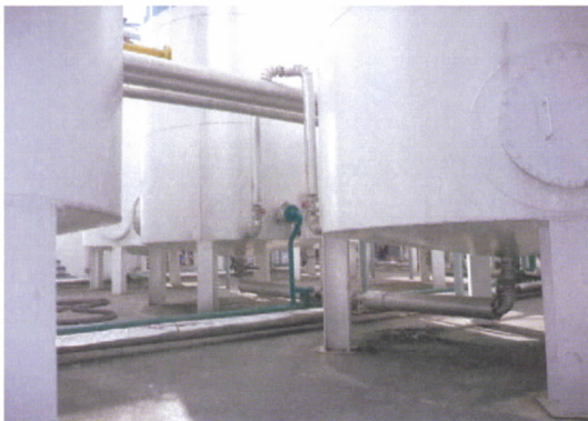
油槽皆採直立式及底部採 V 型設計
