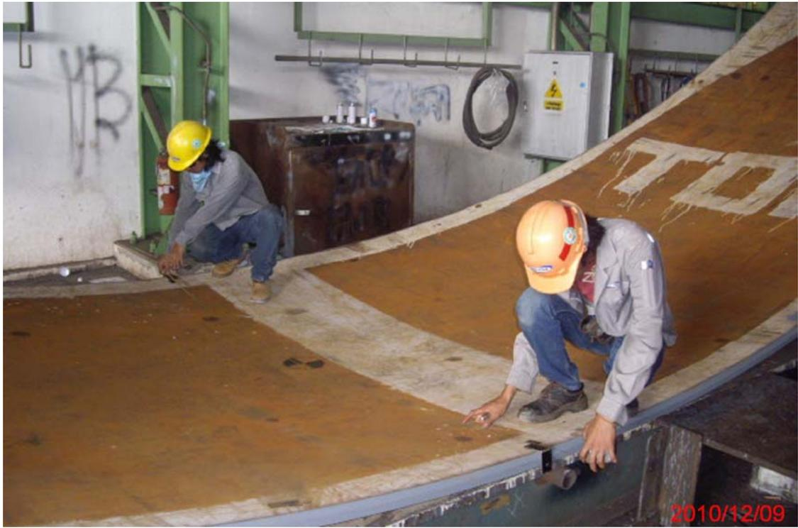
圖二十二：量測完成鋼板暫存堆放待開槽面作防銹處理
