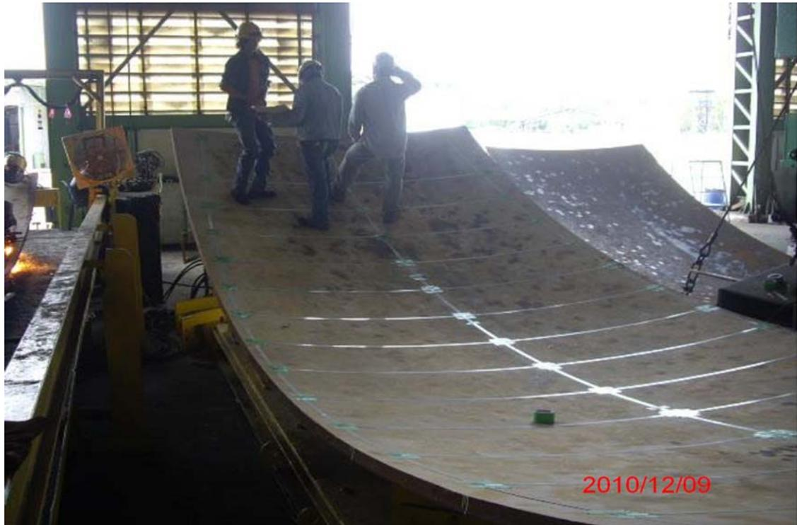
圖十五：鋼板開槽角度切割情形
