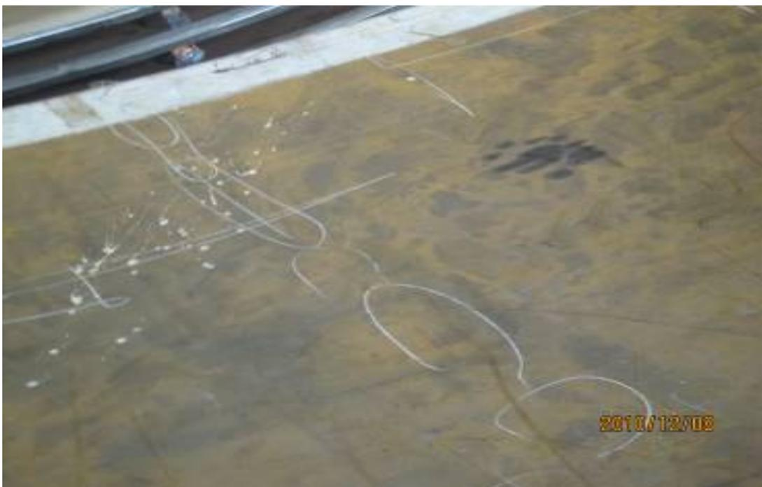
圖十八：曲率量測不合格鋼板送回重新修正情形
