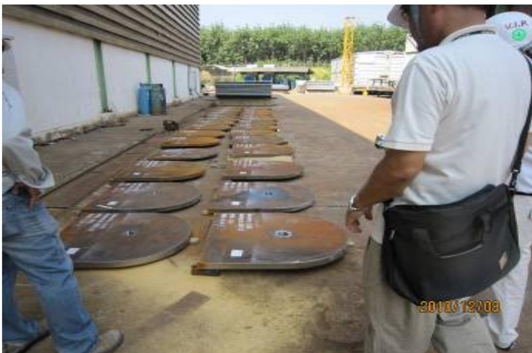
圖二十五：球槽支柱上蓋板預製施作完成打包情形
