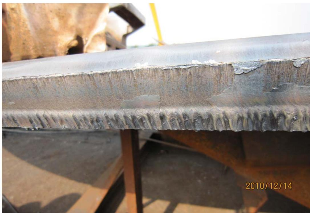
圖二十七：SHI-ASIA 球型槽開槽角度施工情形
