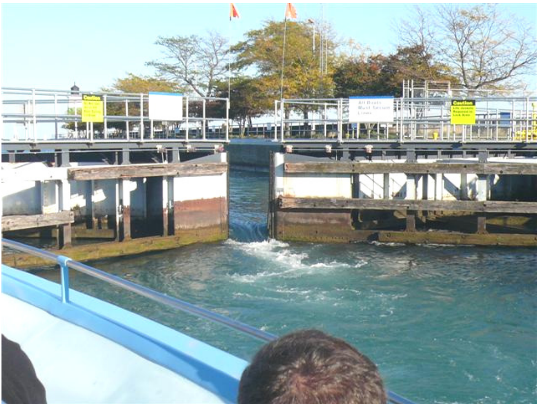
閘門打開後，密西根湖湖水(水位較高)流入芝加哥河
