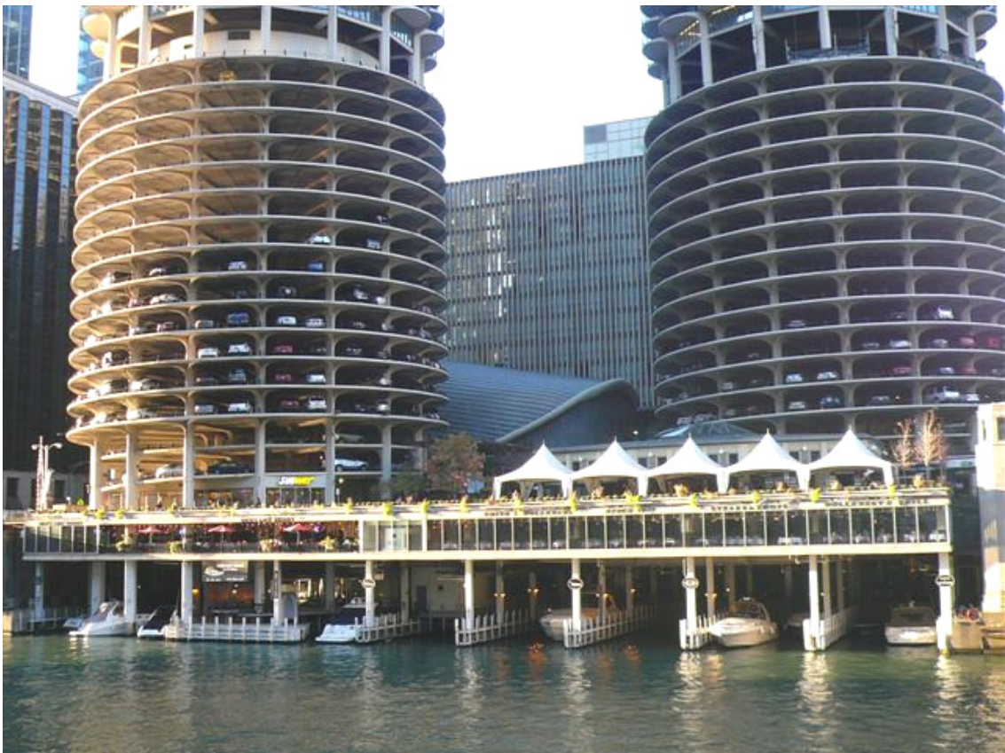
芝加哥河旁建築物下層即與河流相通，除可作為遊艇停泊，亦可吸納較多洪水
