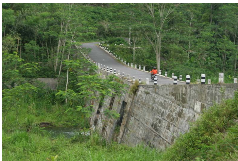
圖 5 防砂壩(與道路共構)
