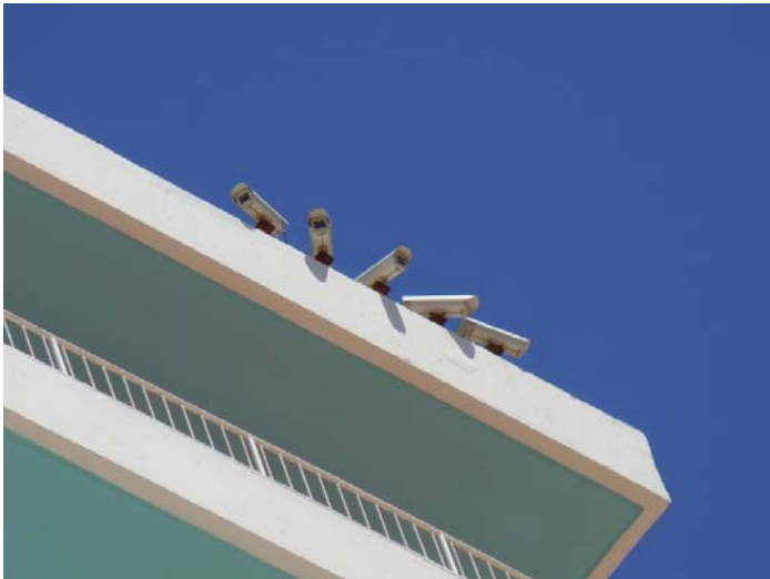
FLIGHT DECK BUILDING 頂樓之 5 之攝影機
