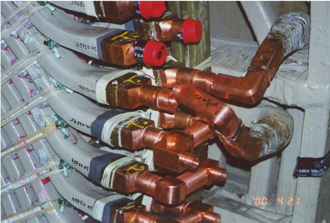
圖 9：定子冷卻水外滲而更換線圈
