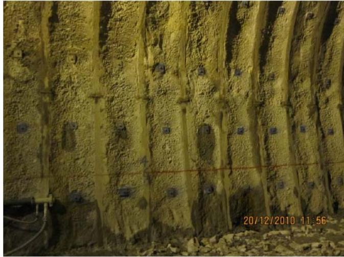
襯砌作業不待貫通，與開挖分段前後同時施工，縮短工程工期。合適斷面之隧道可以參考檢討可行方案加予採用。
