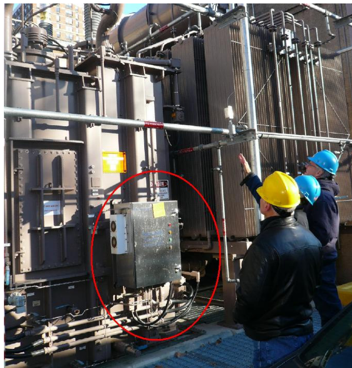
圖 8 裝於電力變壓器上之 GE Kelman TAPTRANS
