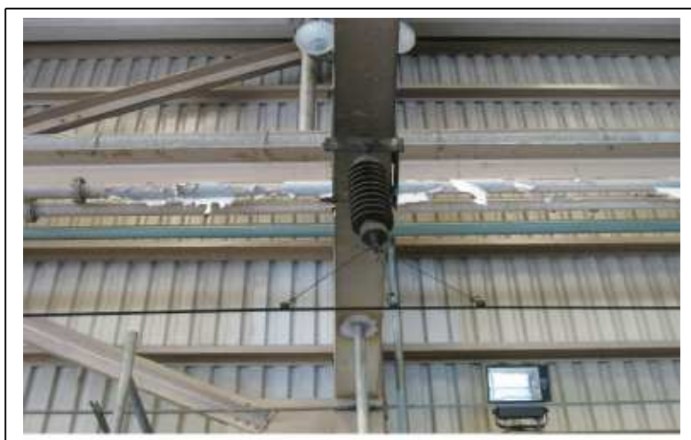
圖 8-7 維修坑股道懸掛接觸線
