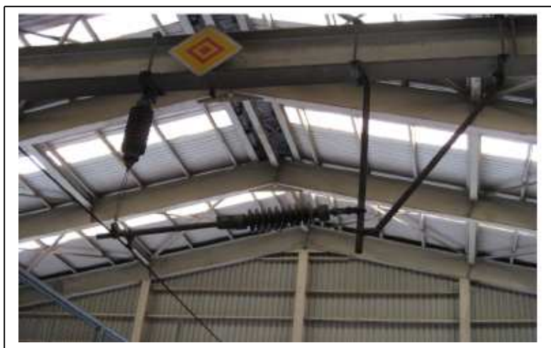
圖 8-8 維修坑股道懸掛接觸線
