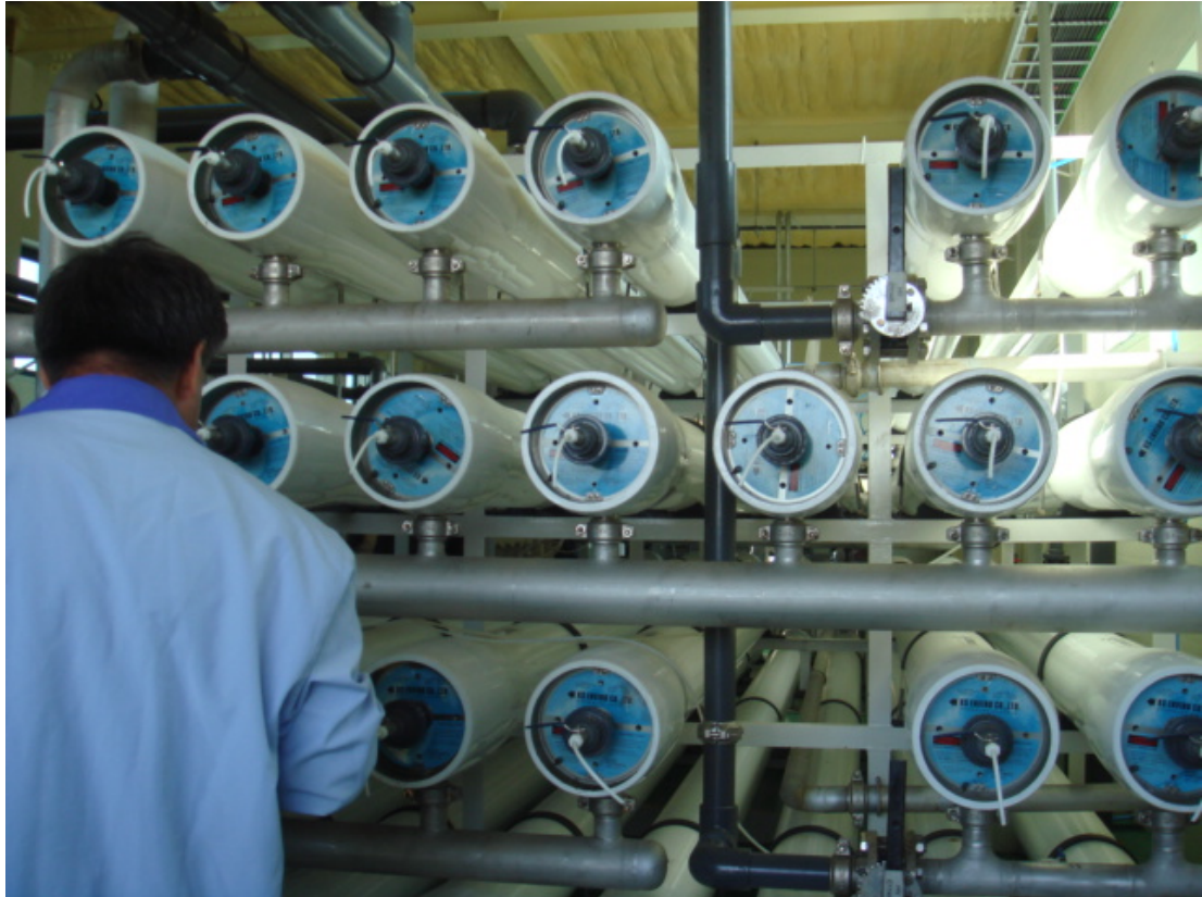
照片 3.2-3 廢水再利用計畫 Panpo 污水處理設施參觀 (Wastewater reuse project - Panpo sewage treatment facilities)
