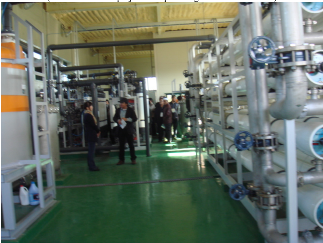
照片 3.2-4 廢水再利用計畫 Panpo 污水處理設施參觀 (Wastewater reuse project - Panpo sewage treatment facilities)
