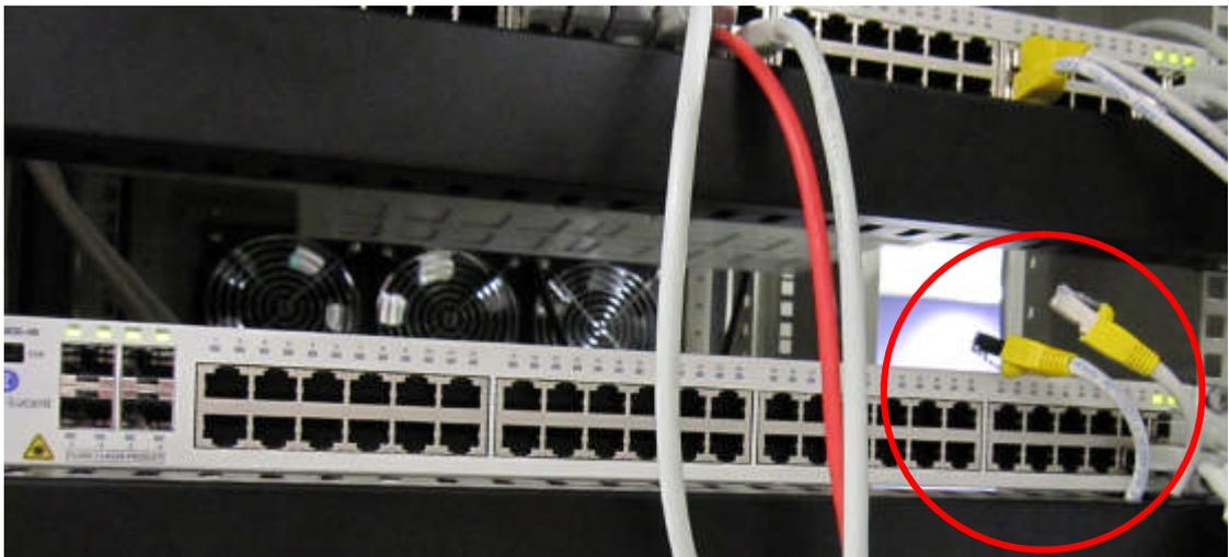
圖七十 拔除節點一內第一台網路交換器到第二台網路交換器的網路線
