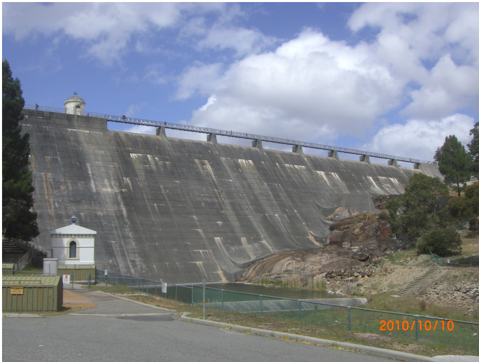
附圖 3 說明：10/10 利用公餘時間自費前往 Mundaring Weir，照片由下游往上游攔河堰方向拍攝，圖片中可見該攔河堰右側岩盤基礎良好，故興建攔河堰時並未將基礎移除後再建，對國內而言實屬特殊案例。
