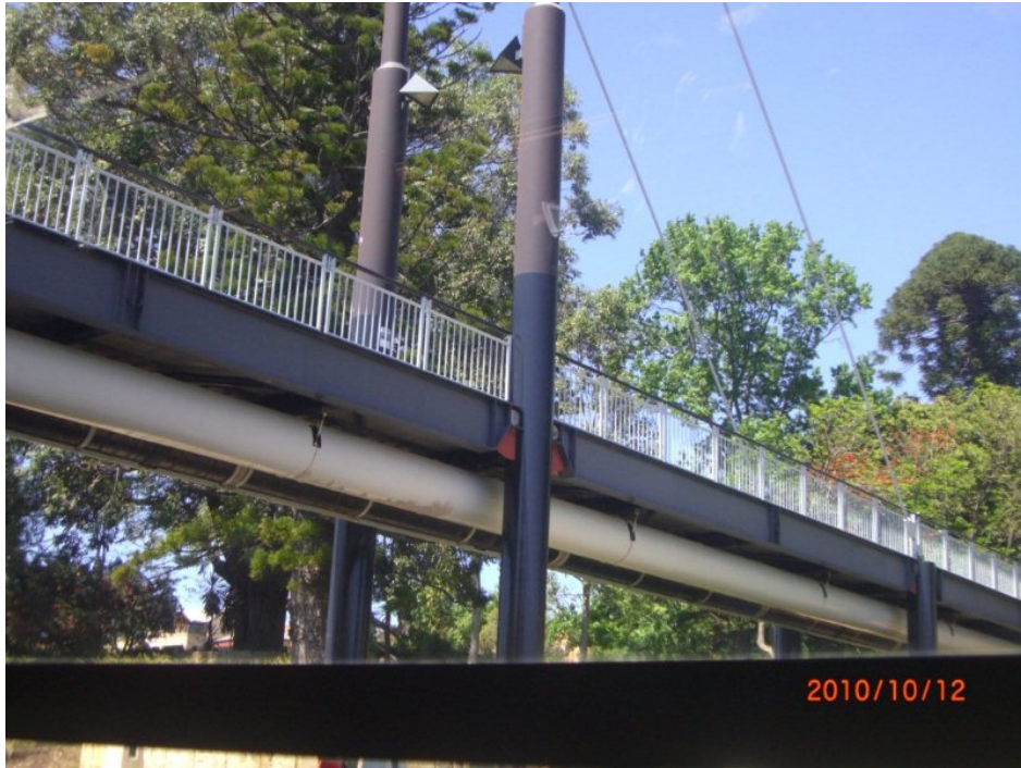
附圖 9 說明：10/12 參加 Swan River Restoration Study Tour 所見跨 Swan River 橋樑，由圖中可見其送水管與橋樑共構，與國內一般橋樑與輸水管單獨設置情形不同，此方式可減少橋墩設置數量並可提昇與環境之調和。
