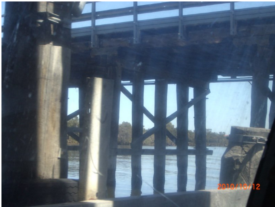
附圖 10 說明：10/12 參加「Swan River Restoration Study Tour」所見跨 Swan River 橋樑，圖中可見就地取材使用木材作為橋樑墩座支撐材料，經個人評估該地因河川流量及水位變動小，有其設置條件，與國內環境太不相同。
