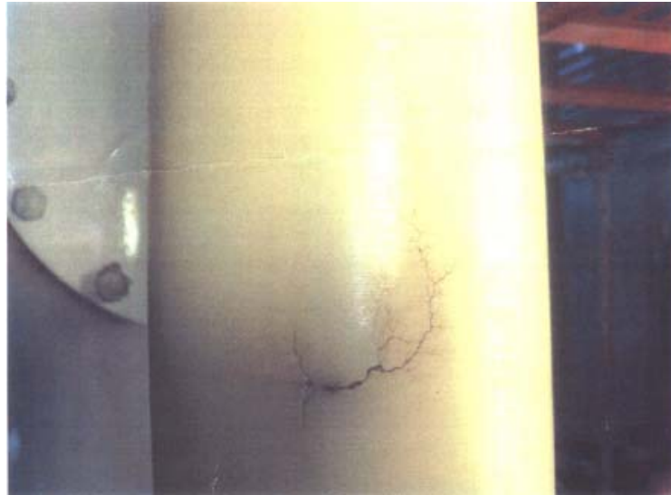
圖 4-20：XLPE 電纜局部放電量測系統發現電纜不良局部放電
