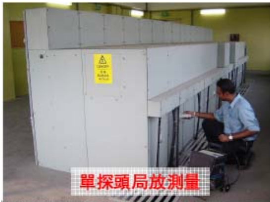
圖 4-5：暫態對地電壓量測法(單探頭式及雙探頭定位式)
