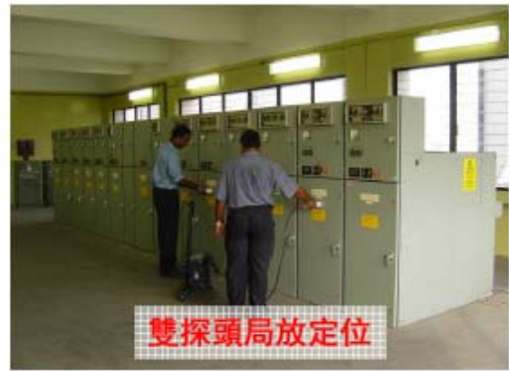
圖 4-5：暫態對地電壓量測法(單探頭式及雙探頭定位式)
