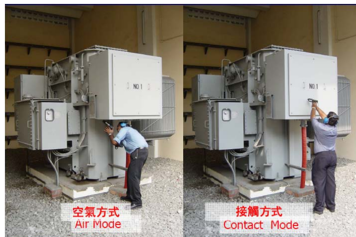
圖 4-4：超音波量測法(空氣式及接觸式)
