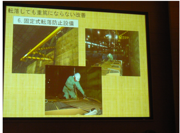
照片 8. 固定式臺架搭配背負式安全帶以防止墜落發生
