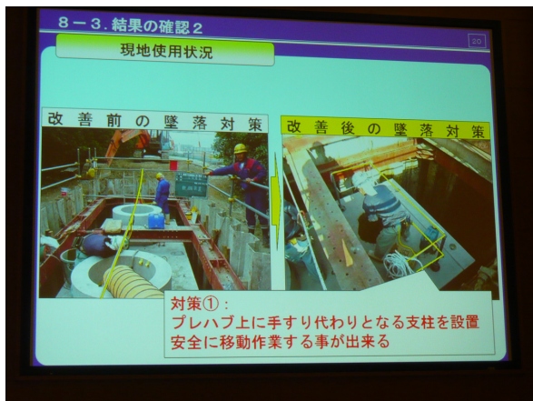
照片 11. 箱涵施工時所架設之墜落防止裝置
