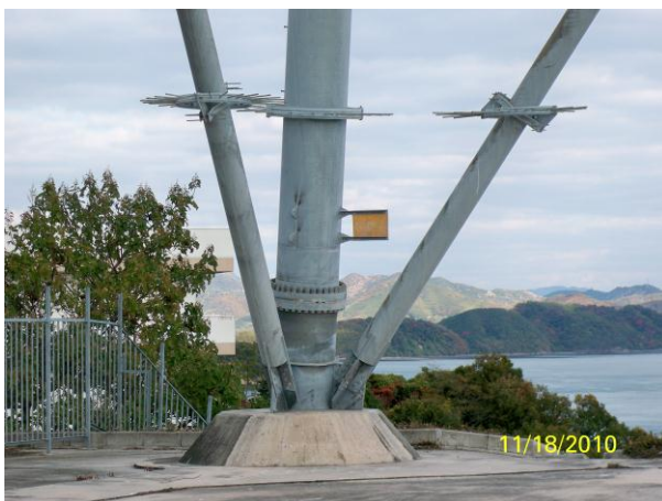
中空鋼管鐵塔
