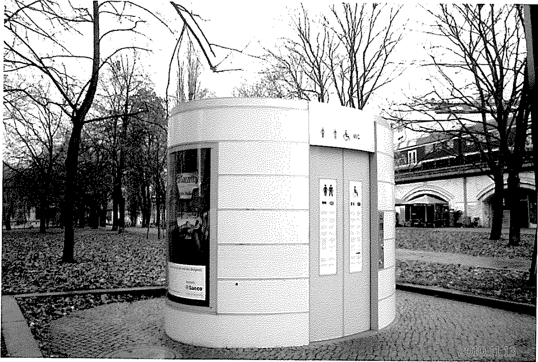
△柏林市區於公園內設置美觀大方，小巧實用之投幣式公共廁所，讓民眾有舒緩身心之方便處。
