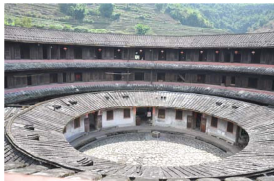
土樓內部結構
