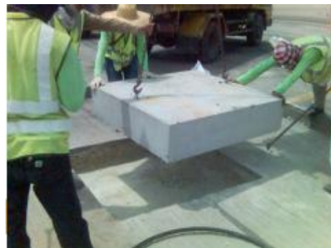
圖、裝置混凝土基腳
