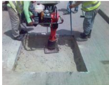
圖、準備裝置混凝土基腳
