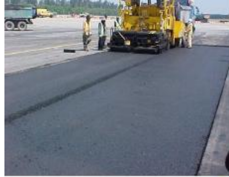
圖、攤鋪機用於攤鋪整平與熨平，已達到所需的厚度與斜度
