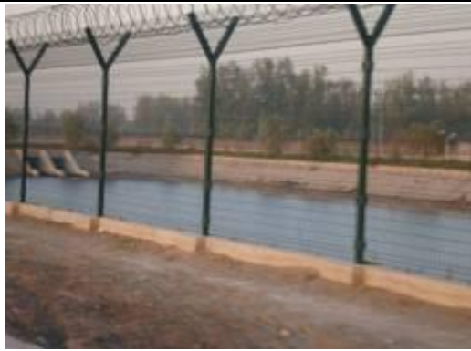
圖、排水蓄洪池
