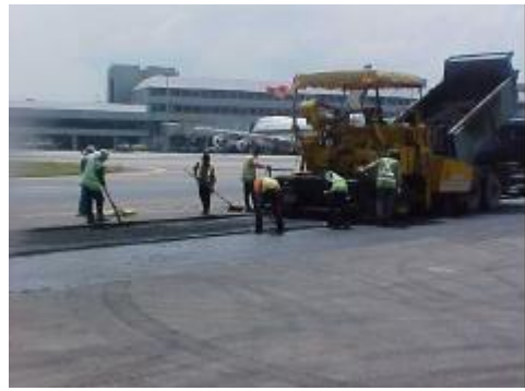
圖、卡車把已拌合的瀝青混合料倒入攤鋪機的料斗
