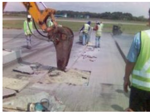
圖、挖掘瀝青層面以裝置混凝土基腳
