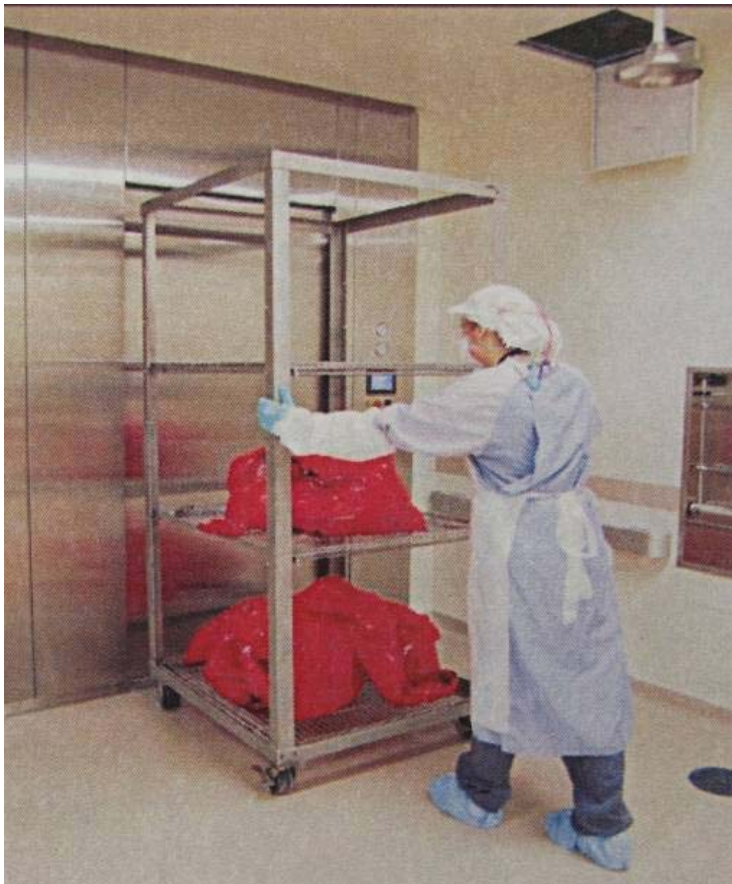
附圖四：固態廢棄物處理室之超大型雙門高壓滅菌器
