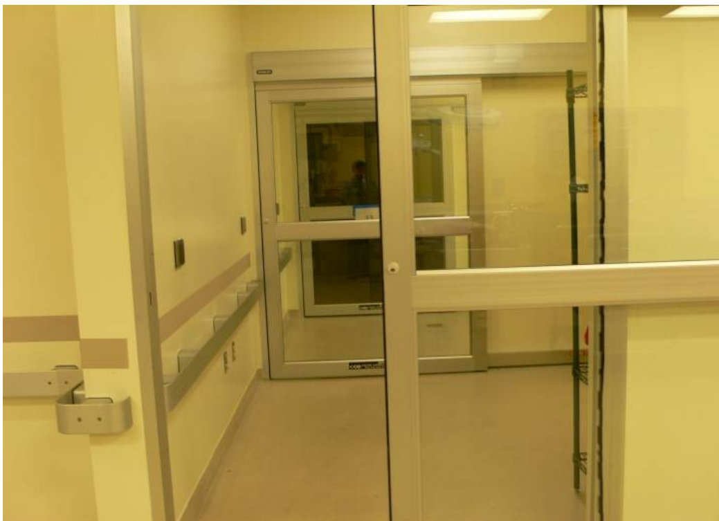
附圖十：雙門氣閘系統，等一邊門關閉時，另一邊門方能打開
