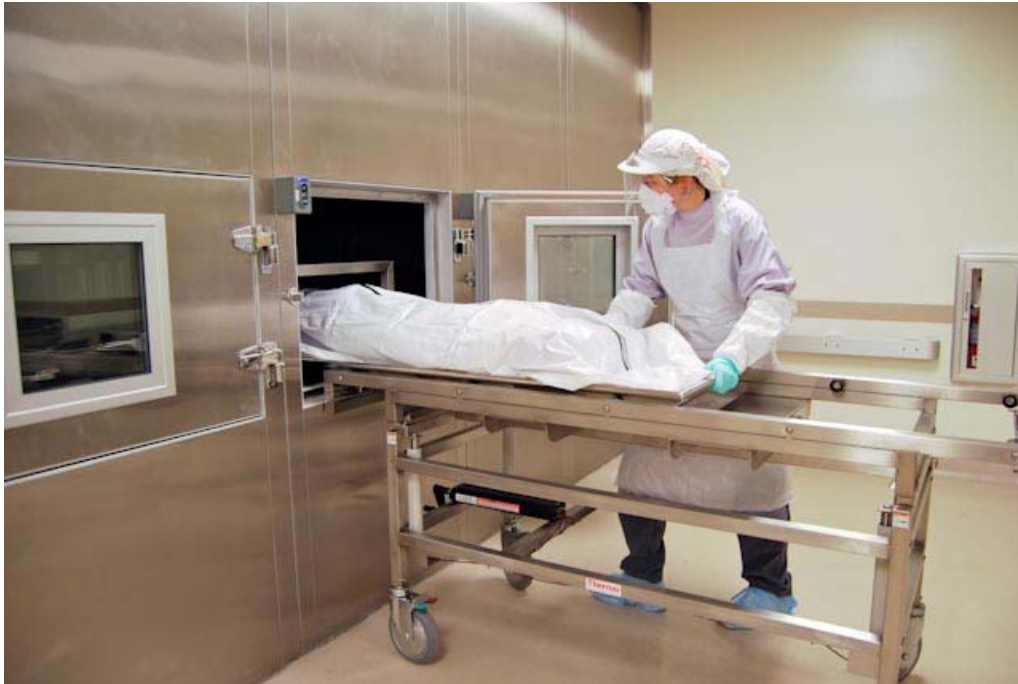
附圖五：停屍間與解剖室之間的雙門傳遞系統
