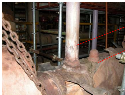
反應器的 quench 氫氣注入方式。
