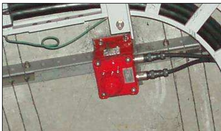
照片 3-22 為熱線型半導體式可燃性氣體感應器之範例
