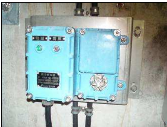
照片 3-20 氧化鋯固體電解式氧氣濃度感應器
