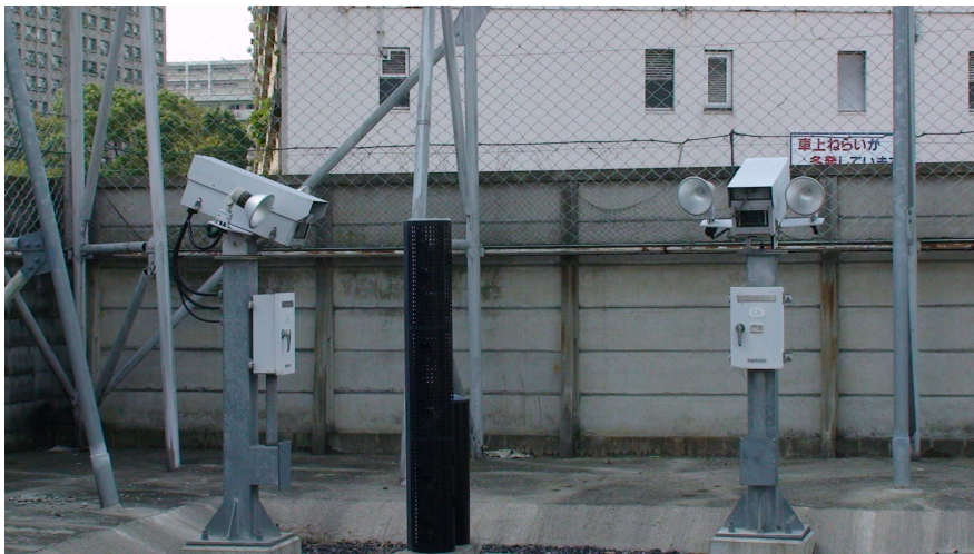
照片 3-6 紅外線感應器配合監視及照明設備
