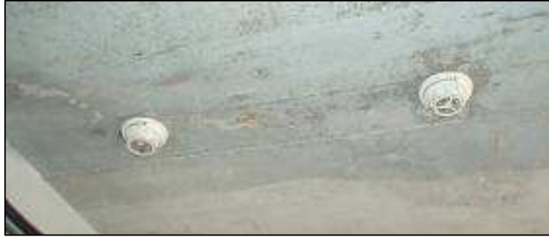
照片 3-8 熱感應定溫焦點型(防水型)感應器
