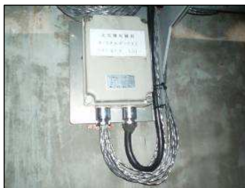
照片 3-7(2) 偵測線接線盒(Terminal Box)
