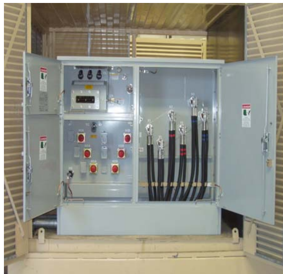
內建雙繞組變壓器 500kVA 或 1MVA，中壓熔絲
