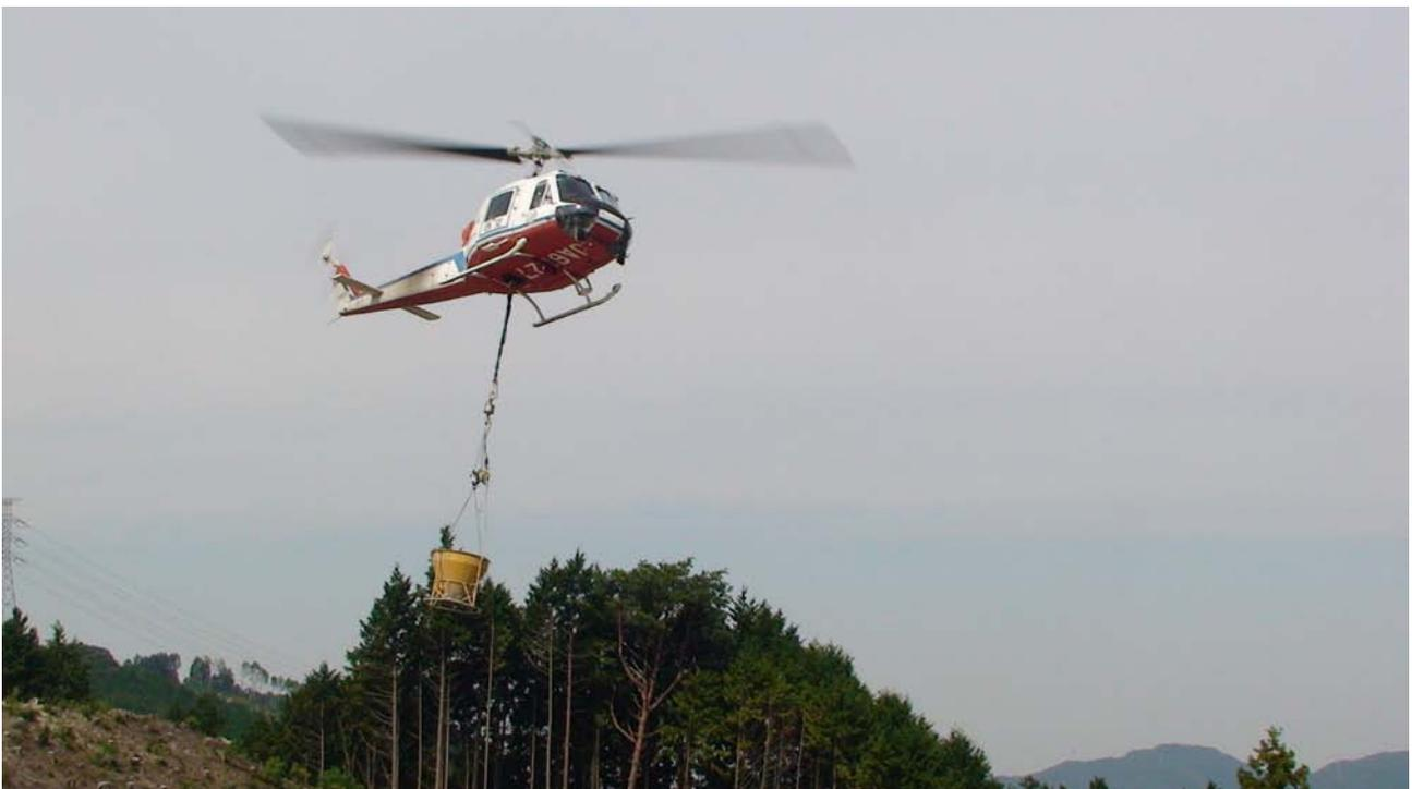
圖 3-8、應用直昇機於鐵塔工事示意圖-2
