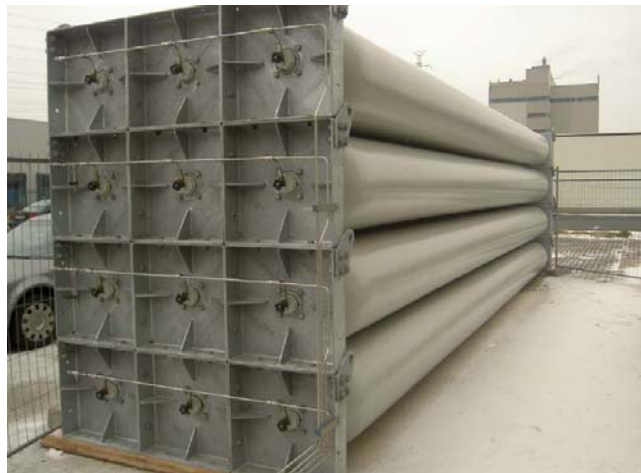
圖 9 氣體回收儲槽
