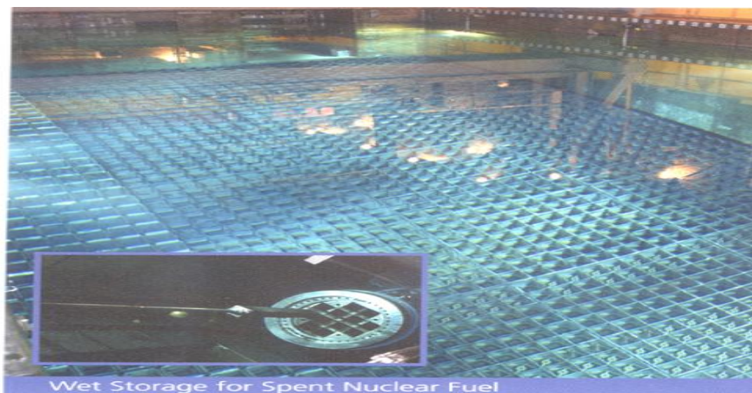
圖 2-3-8 用過核燃料濕式貯存
