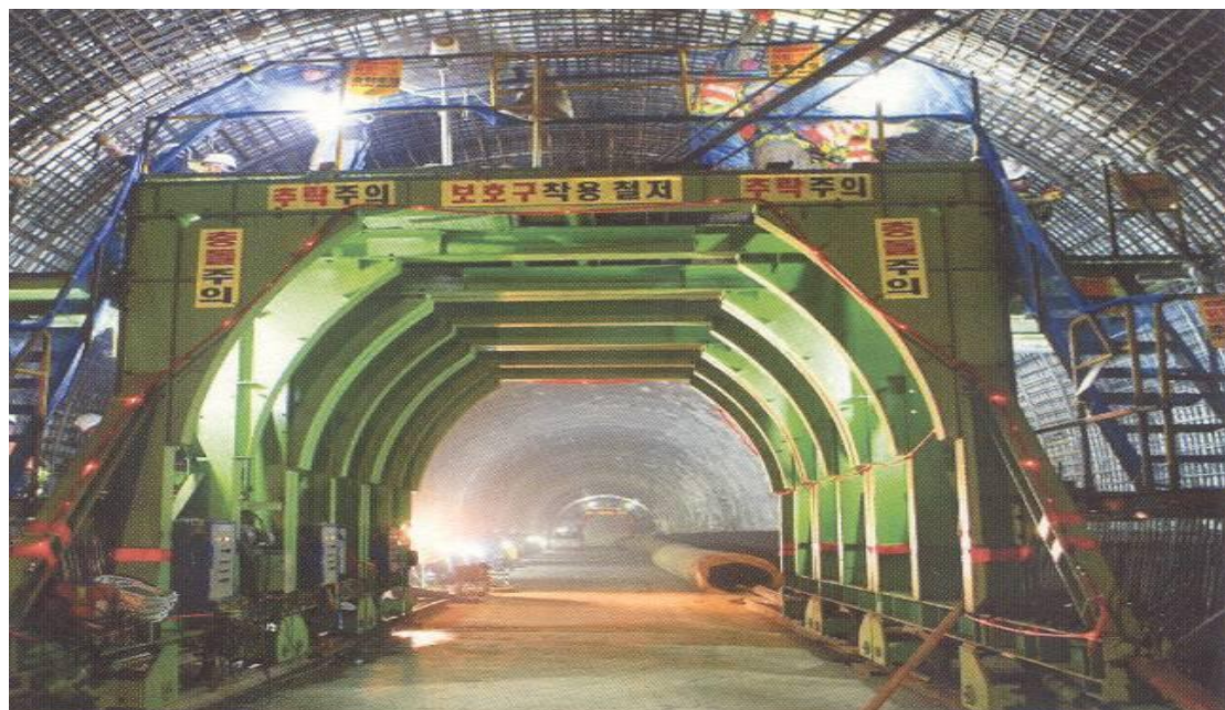
圖 2-3-5 月城中低放處置場地下設施之建造坑道
