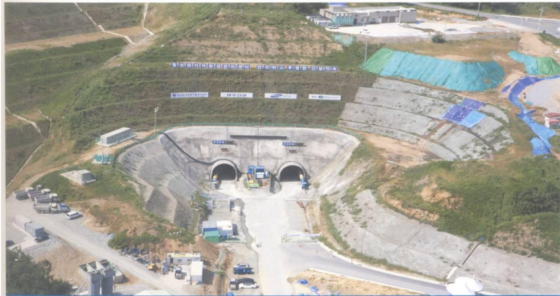
圖 2-3-6 月城中低放處置場地下設施之運轉坑道
