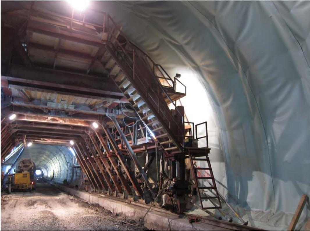
照片 14 襯砌鋼模及進行襯砌混凝土澆置
