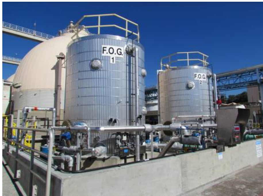
圖 11 蛋形消化槽利用 FOG 系統進行綠能再生計畫 (2)許可管制及審核
