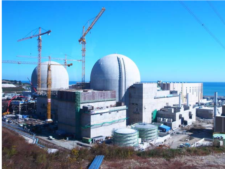
圖 17 正在建造中之新月城 1 號及 2 號反應爐
