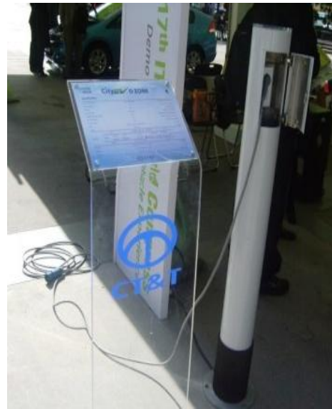
圖 39 CT&T/ e-Zone 充電孔、鋰電池充電器及線路
