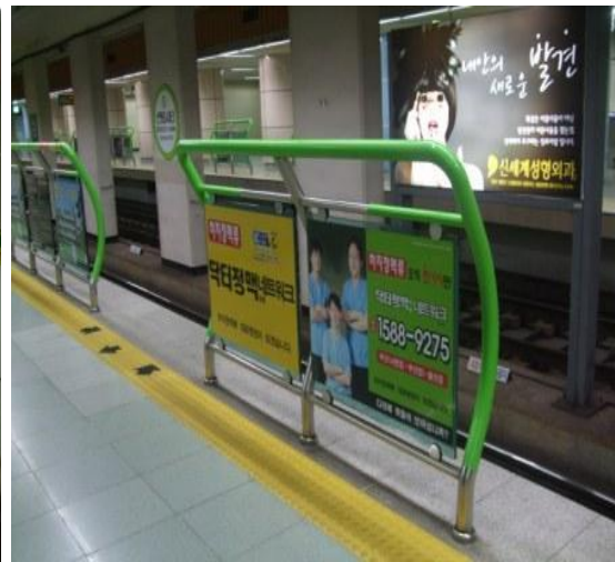
D. 欄杆式防護欄
