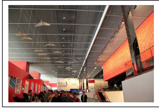
上方自動撒水頭設備
