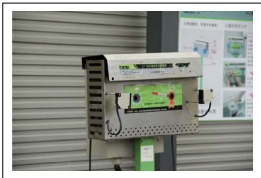
明火管理-吸煙區點煙器
