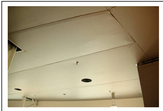
偵煙及撒水設備
