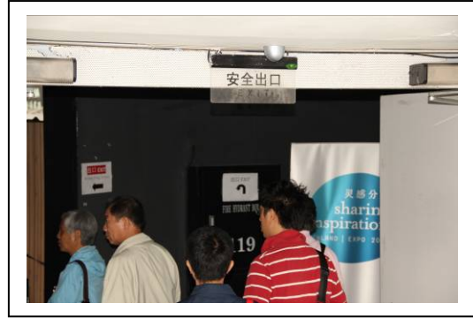
出口指示燈及消防設備
