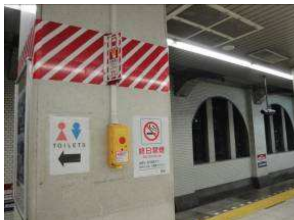
緊急通報鈴位置
