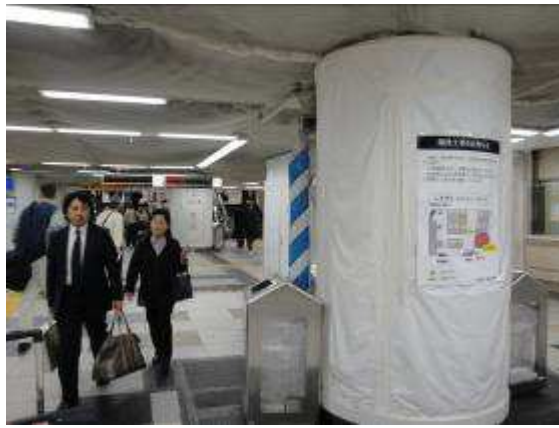
施工處所完全包覆
