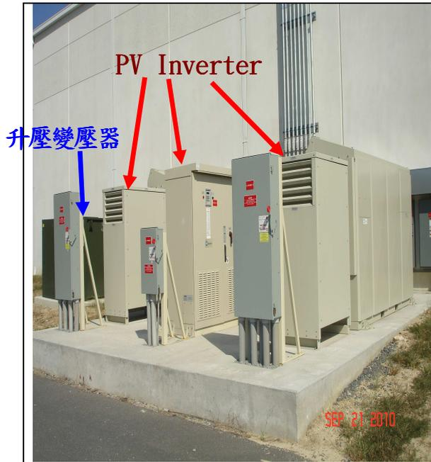
圖 2.17 高壓用戶屋頂 1MWp 太陽光電廠
