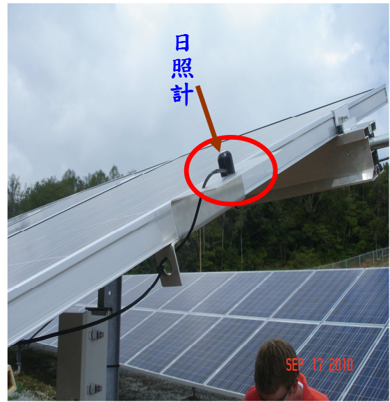
圖 2.8 1MWp 太陽光電廠(b)- 日照計
