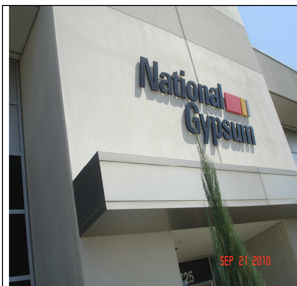
圖 2.13 高壓用戶屋頂 1MWp 太陽光電廠 (a) - 高壓用戶名稱
