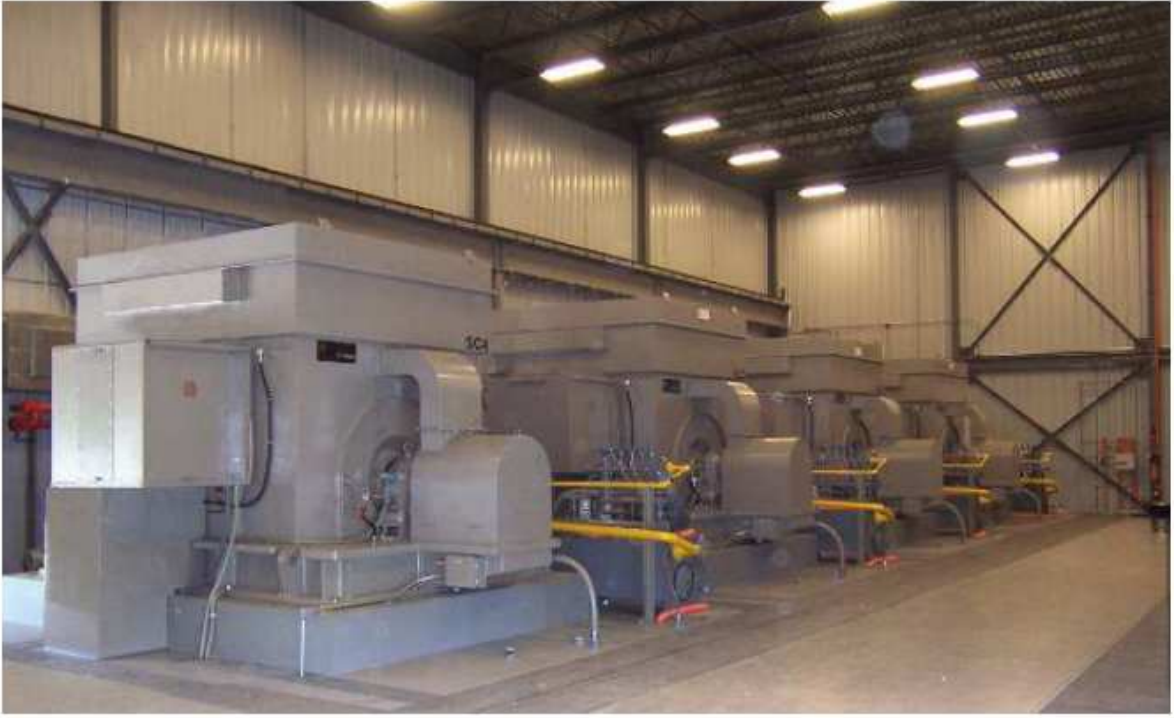
圖 20 在 Vermont 的同步調相機
