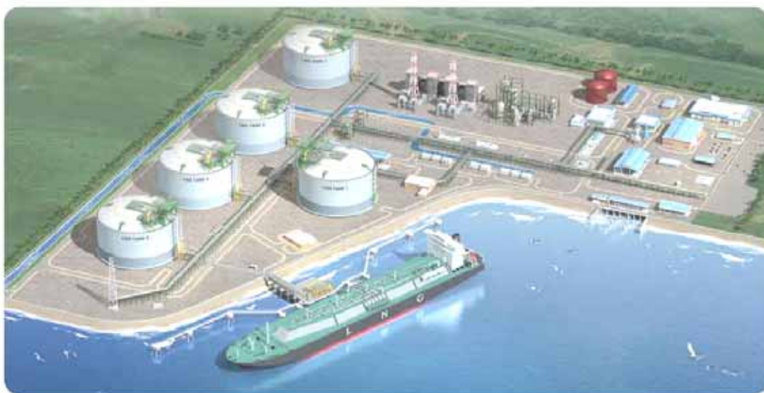
圖 3.6 興建中之 LNG 接收站
