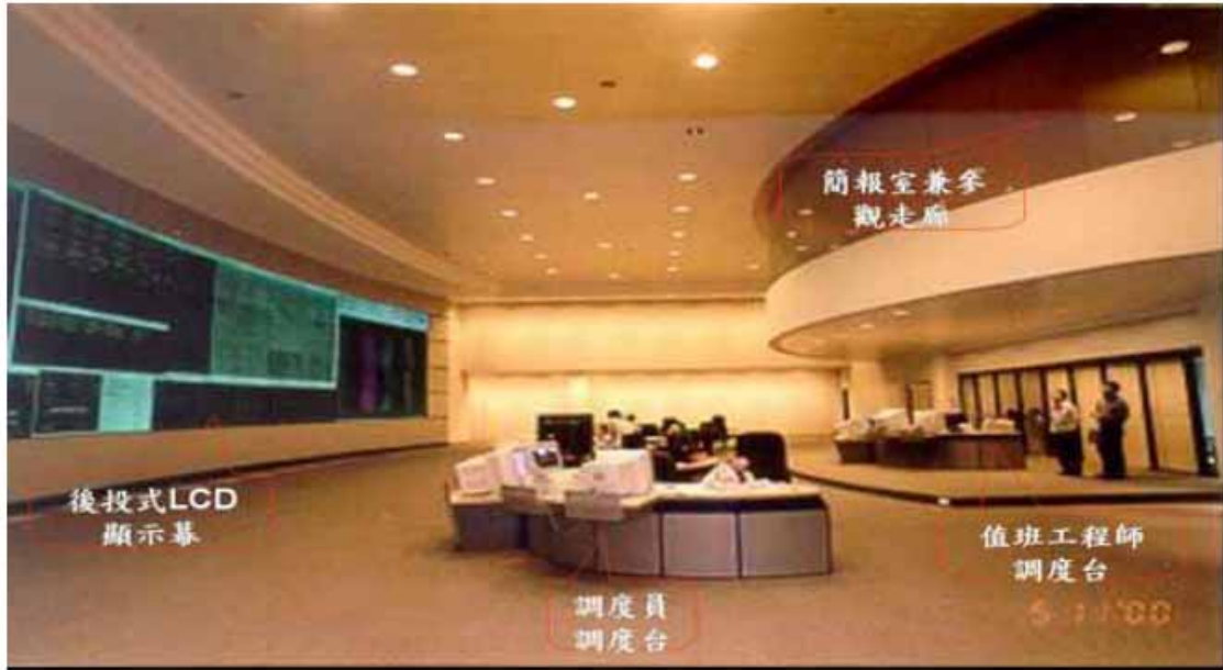
圖 3.17 PSCC 控制室配置圖
