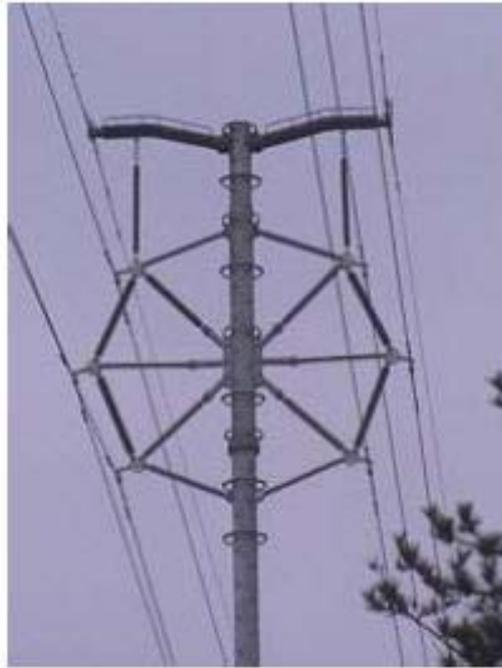
圖 5-3 降低電磁場鑽石型輸電鐵塔設計
