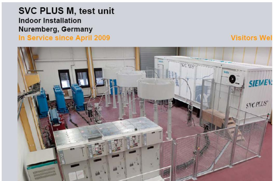
圖 7-6 SIEMENS 德國紐倫堡工廠模組化設計之 STATCOM (SVC PLUS)
