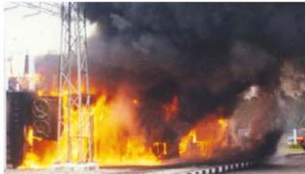
圖 5-4 變壓器火災/OIP 套管故障油噴出引起
