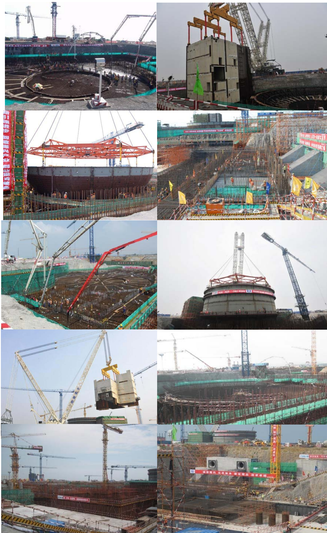
青島海陽核電站施工現況
