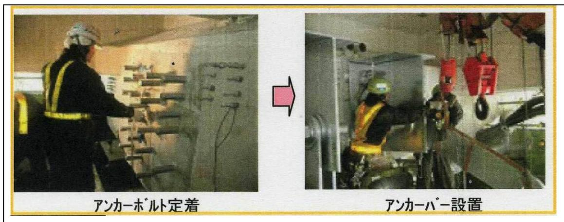
圖 3-14 抗拉拔裝置設置
