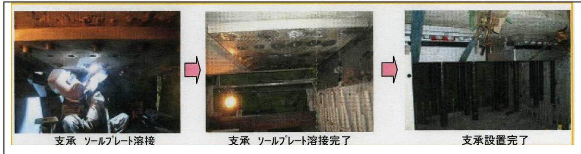
圖 3-12 新設支承墊設置
