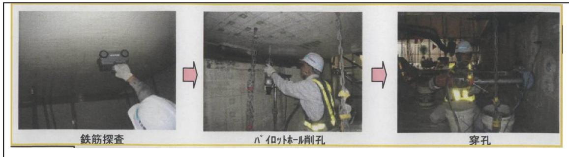
圖 3-2 梁底錨定鑽孔
