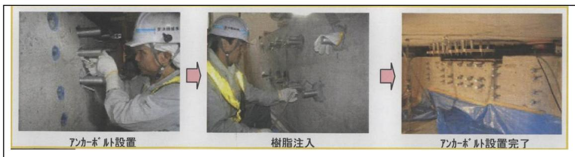
圖 3-4 新設支承墊錨定鑽孔
