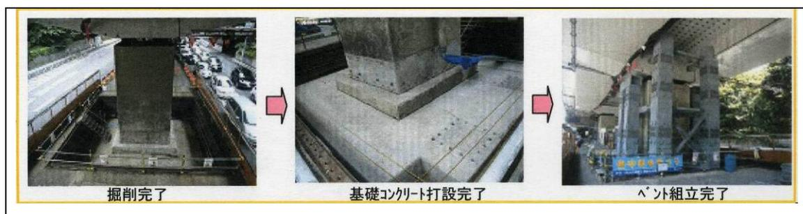
圖 3-8 假設反力支柱設置
