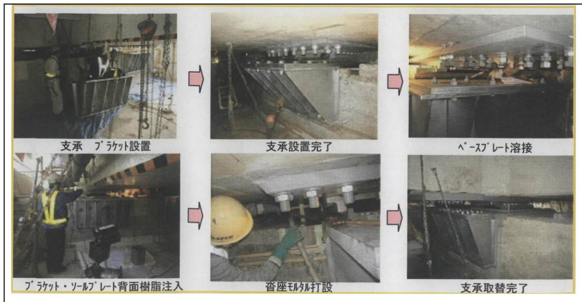
圖 3-5 新設支承墊設置
