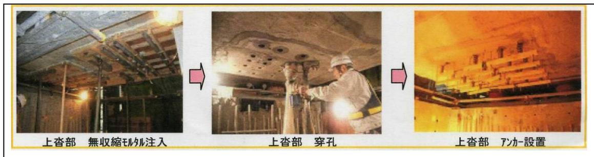
圖 3-11 新設支承墊錨定鑽孔
