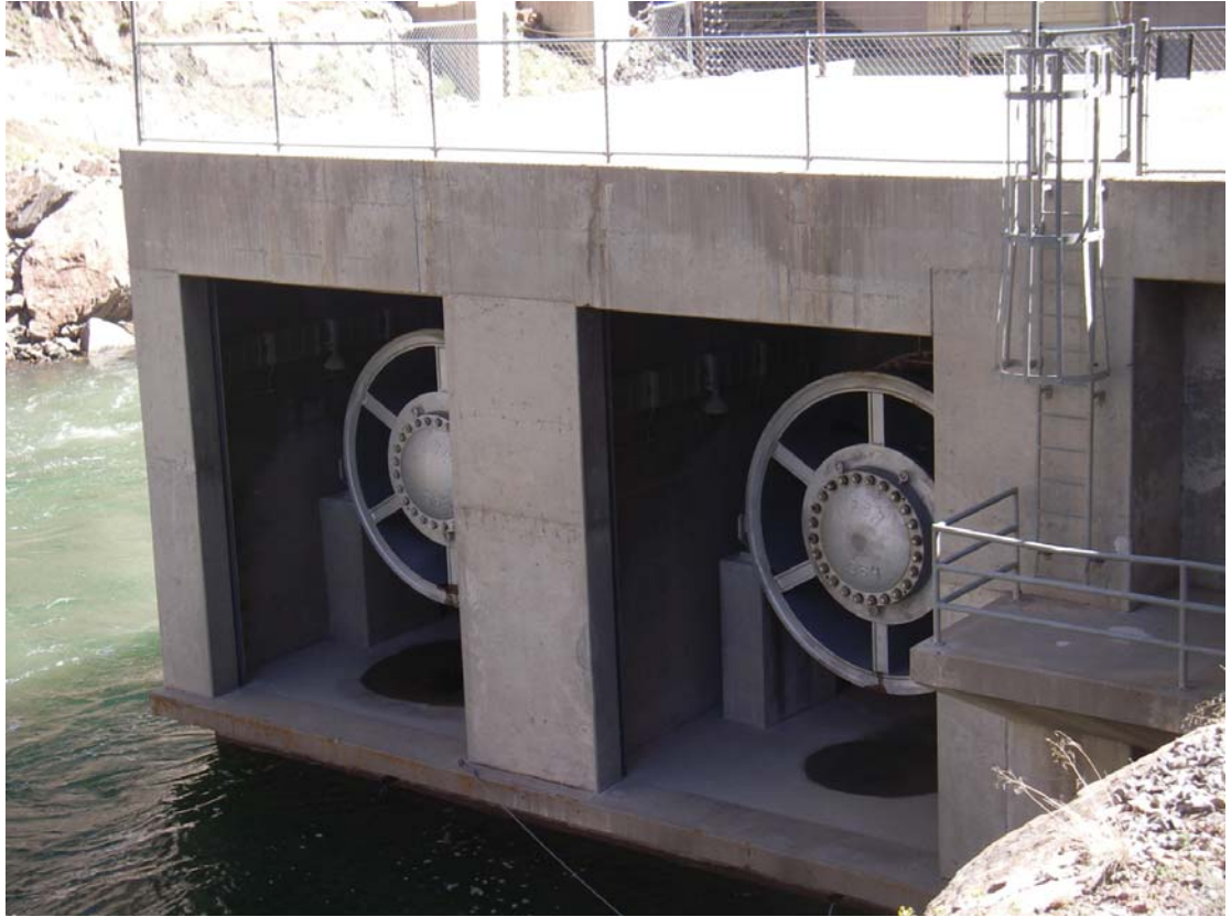
照片 6 布魯梅薩（Blue Mesa）壩出水工出口中空噴射閥
