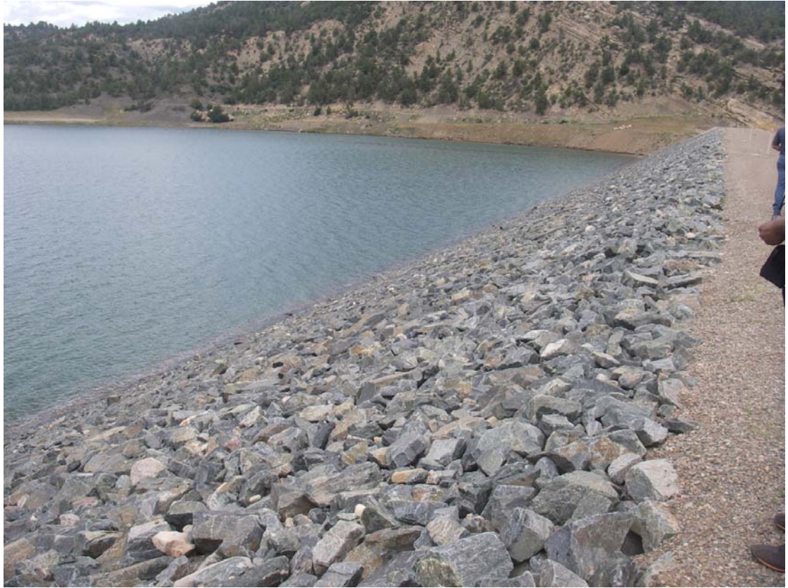
照片 11 山脊盆地 (Ridges Basin) 壩上游面塊石拋石層
