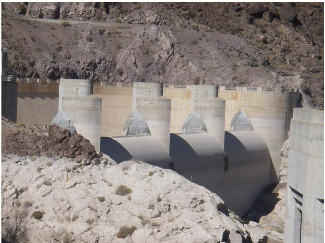
照片 22 胡佛壩側渠溢洪道
