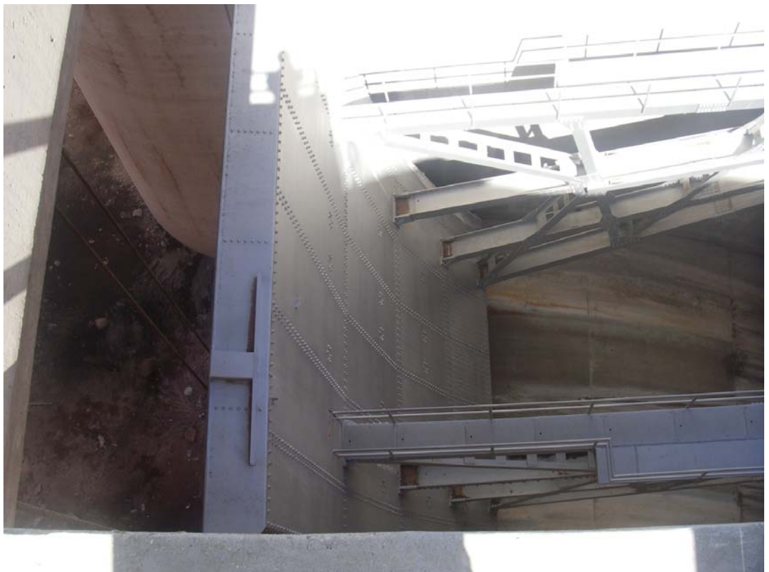
照片 17 格蘭峽谷(Glen Canyon)壩溢洪道弧形閘門
