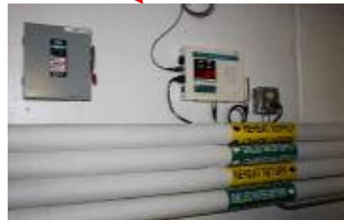
射束前進線旁光子劑量率偵檢器。(找不到固定式的中子劑量率偵檢器，中子劑量率偵檢器為手提式的，每月使用一次。)
