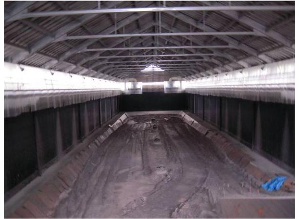
圖 15. 倉儲式最終處置廠內部實況-以榻榻米保護不透水布
