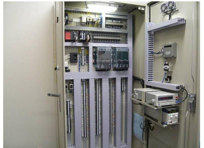
圖 25. 室內電子偵漏系統裝置
