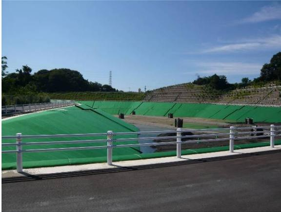
圖 2. 知多市東鴻之巢最終處置場-不透水布鋪設
