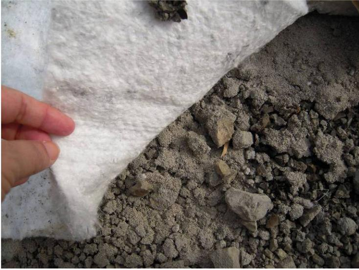
圖 39. 為保護不透水布，於地基上鋪設保護毯，並先以混凝土固化尖銳之石塊
