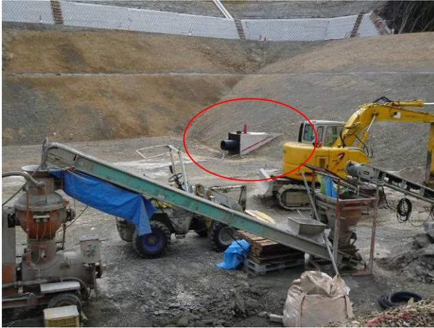
圖 33. 處置場底部施工情形圖(紅圈處為掩處置場之心臟-滲出水收集管)
