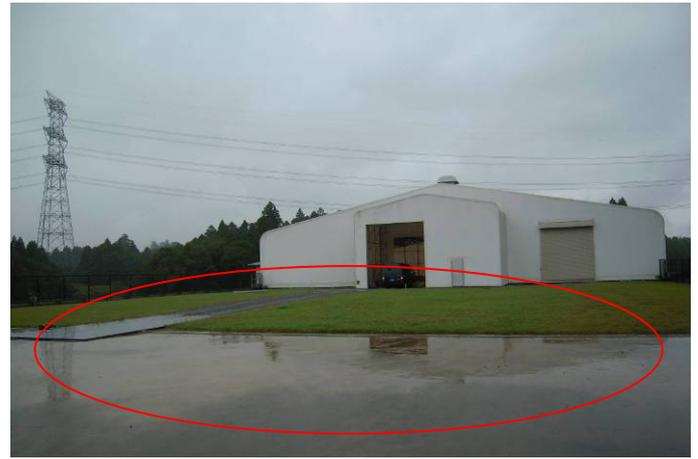
圖 45. 已掩埋終了之第一槽體，以最終覆土及植栽進行封閉
