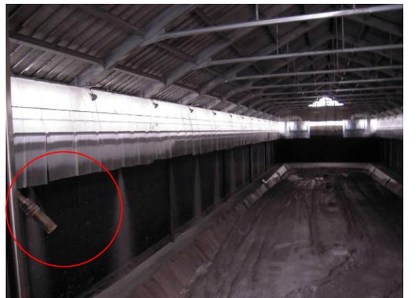
圖 17. 紅圈處為洒水裝置，每日按時洒水
