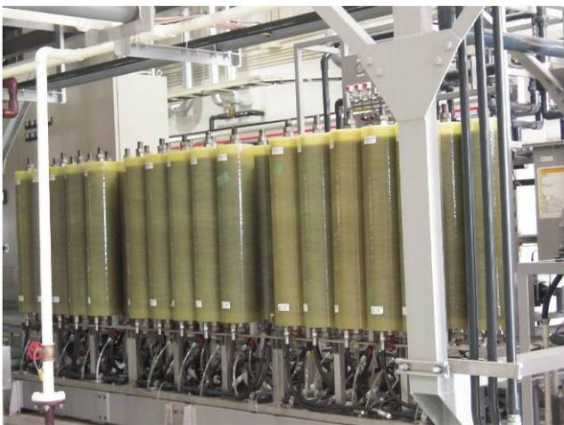
圖 28. 水處理設施逆滲透薄膜處理裝置
