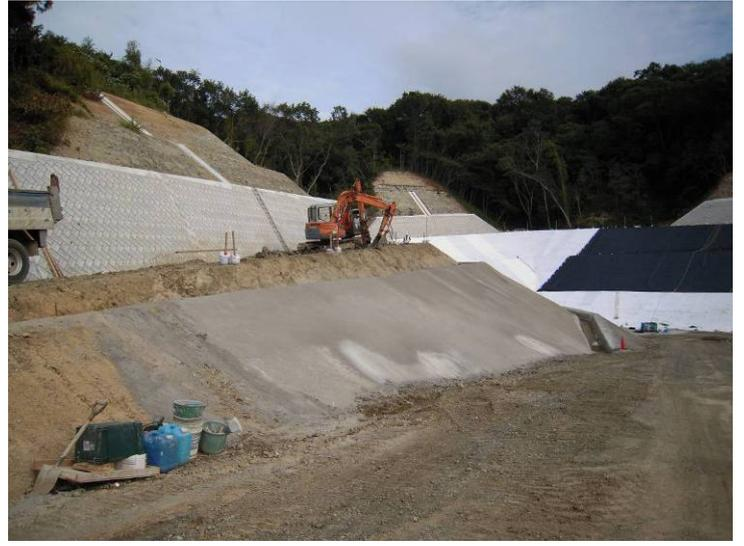
圖 40. 該地區大部分為堅硬之岩石層區，為避免不透水布遭刺破，先地基岩石敲碎並鋪混凝土使表面較平滑
