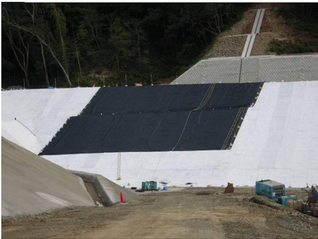
圖 35. 處置場不透水布施工圖
