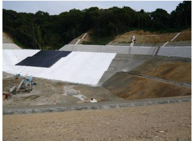
圖 34. 處置場不透水布施工遠眺圖
