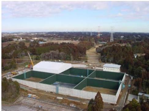
圖 7. 移動倉儲式最終處置場
