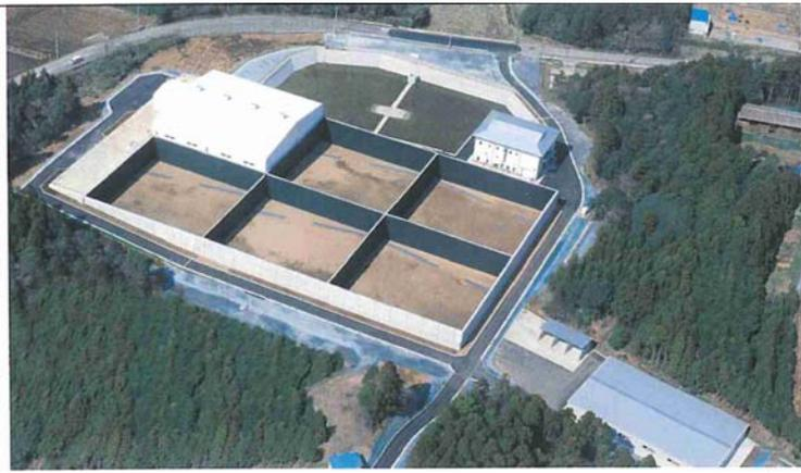
圖 44. 移動倉儲式最終處置廠設施全景(第一槽體已掩埋終了，進行第二槽體掩埋)
