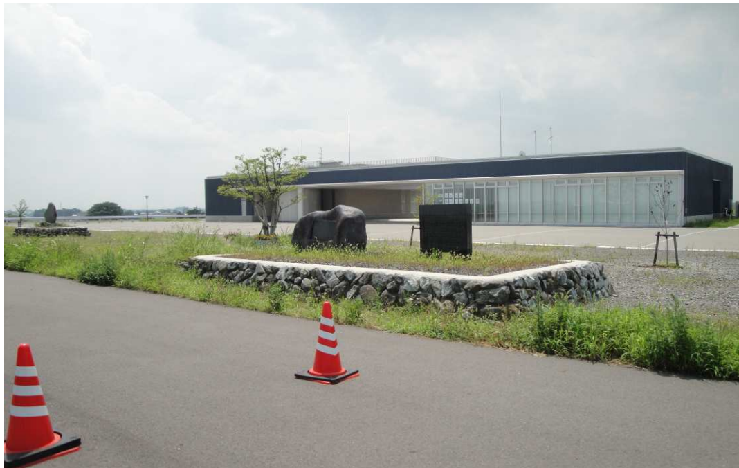
圖 3-17 高規格堤防堤後側所設防汛指揮所
