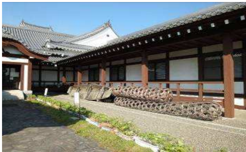
圖 3-23 關宿城舊城遺址前放置舊年河工構造物『竹籠工』
