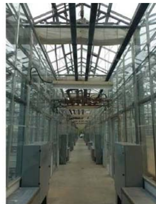
圖40. AAFC之基因轉殖植物中心隔離溫室電力、弱電相關的電箱與控制器安置於通道二側的電箱內
