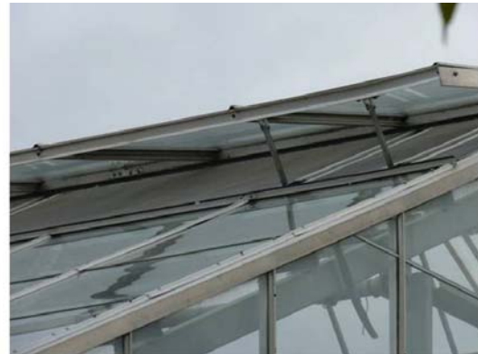
圖48. AAFC之基因轉殖植物中心隔離溫室溫室的天窗外部均包覆有防蟲網的設置，以防止昆蟲與雜物進入溫室
