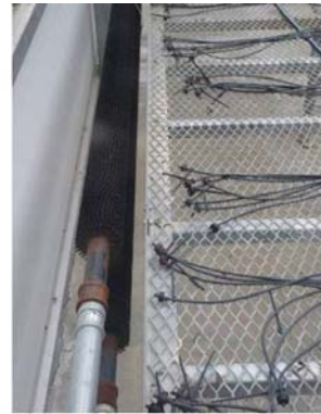
圖42. AAFC之基因轉殖植物中心隔離溫室內加溫用熱水管外部套以分散狀金屬散熱環進行周邊空氣加溫
