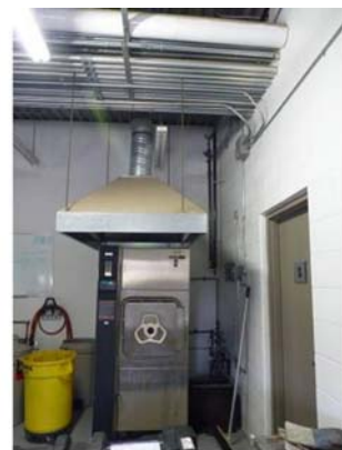
圖46. AAFC之基因轉殖植物中心隔離溫室準備區設有大型角型高溫高壓滅菌釜。
