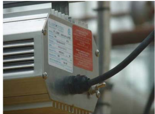
圖44. AAFC之基因轉殖植物中心隔離溫室人工照明採400W植物生長專用高壓鈉燈
